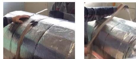
6 : Au besoin, réaliser les liaisons ou étanchéité entre
