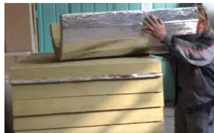
3 : Poser le 1er élément sur le tuyau, puis positionner
