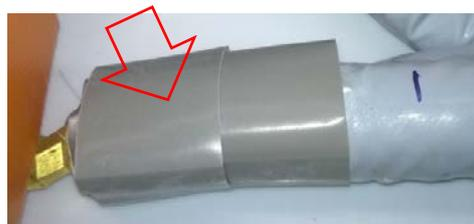
**NOTE :** à la place des manchettes, il est possible d'utiliser un scotch compatible aux conditions d'utilisation : intérieur ou extérieur, température du fluide, etc.
