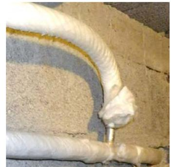
3. Rabattre et stabiliser l'isolant sur le raccord avec un film adhésif pour assurer la continuité de l'isolation en silice amorphe :
