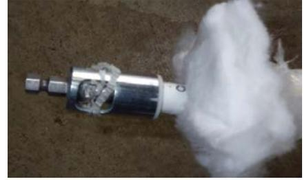
2. Raccorder les tubes multicouches au T, puis les sertir :
