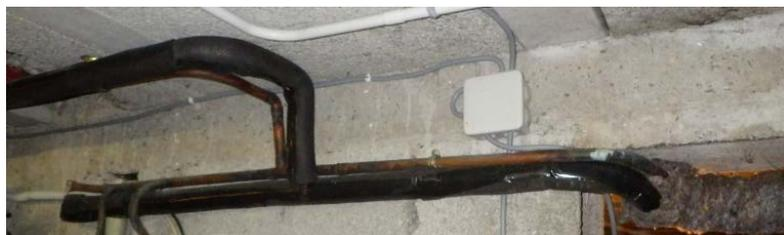
Le réseau cuivre a été refait avec des 2inToob : tubes multicouches pré-isolés avec 10mm de silice morphe.
