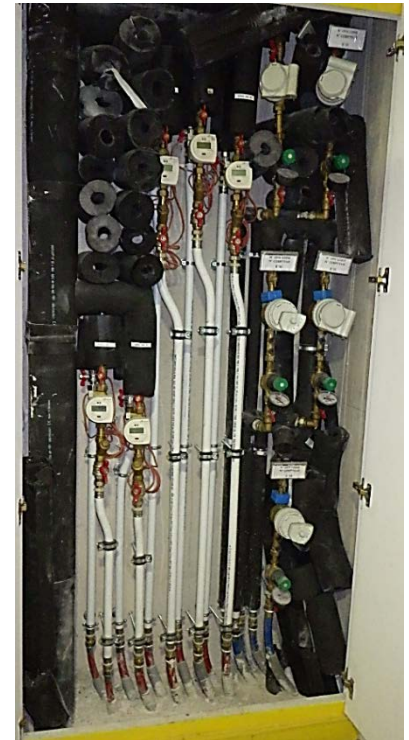
Armoire Technique GT palière, avant la pose des TwinToob
