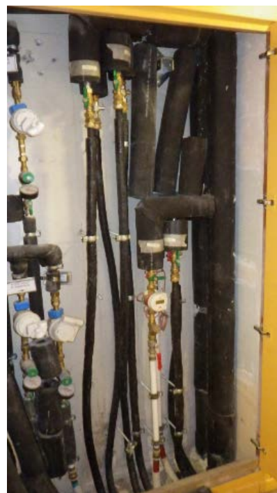
Armoire Technique GT palière avec RenoToob
